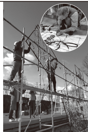
ala クルーズによる製作・設置の様子
