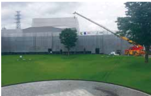
▲ 仮囲いで覆われたala外観
