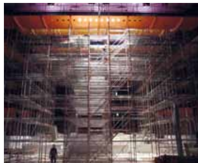
▲ 主劇場 1階客席を全て取り外し足場が組まれ天井改修をしています。
